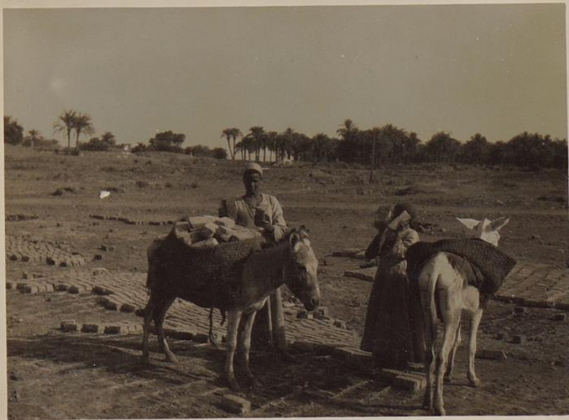
Hermopolis, Hausbrun Esel bringen die unmittlbar neben der Baustelle hergestellten Ziegel heran. Dez. 1929.
