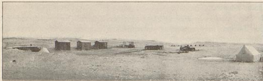
Lager „Meteorfelder“ bei Bogenfels.
