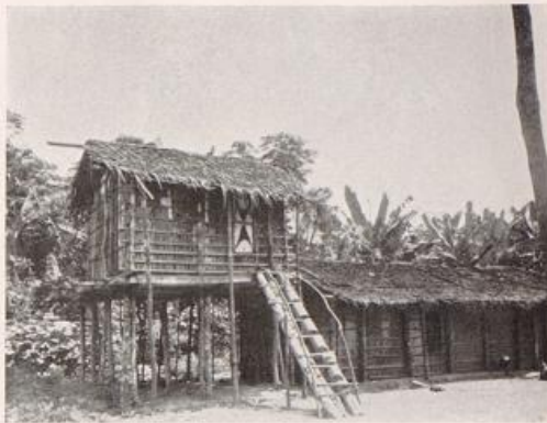
15. Pfahlbauhütte in Anjang (südlicher Ojem-Bezirk).
