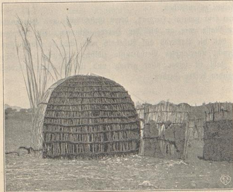
Pontok im Bau.
