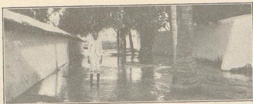
Die überschwemmte Bremer Straße.
