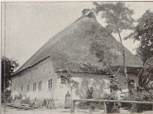
3. Vierständerhaus, Rückseite mit halber Hinterkübbung links (Altrecknitz, Amt Dargun)
