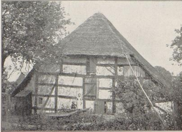
1. Kübbungshaus, jetzt als Scheune dienend; Rückseite (Retzow, südsüdwestlich von Plau)
