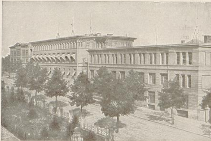
Die Geographische Anstalt von Justus Perthes in Gotha von der Friedrichsallee gesehen (im Mittelgebäude die Schriftleitung der »Deutschen Erde«)
