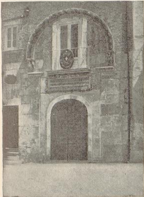
Abb. 12. Der letzte Rest vom glänzenden Palaste Friedrichs II. in Foggia (ein jetzt in einem Privathaus vermauerter Bogen).
