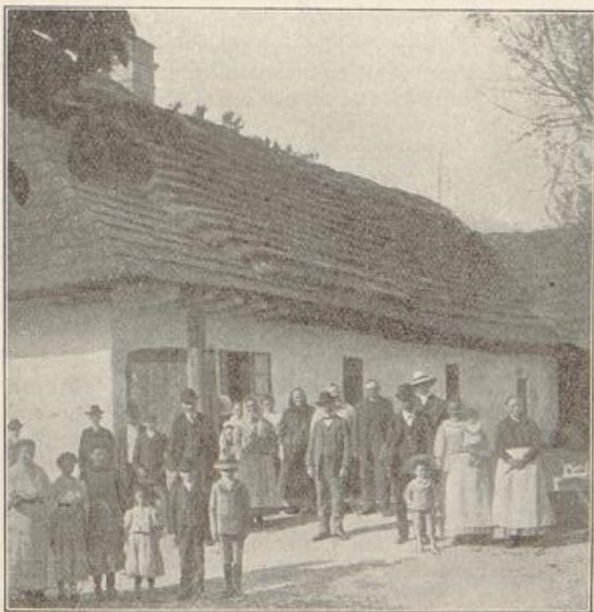
Abb. 24. Josephinisches Haus in Unterbach (Galizien) (das Dach ist teils mit Schindeln, teils mit Stroh gedeckt).
