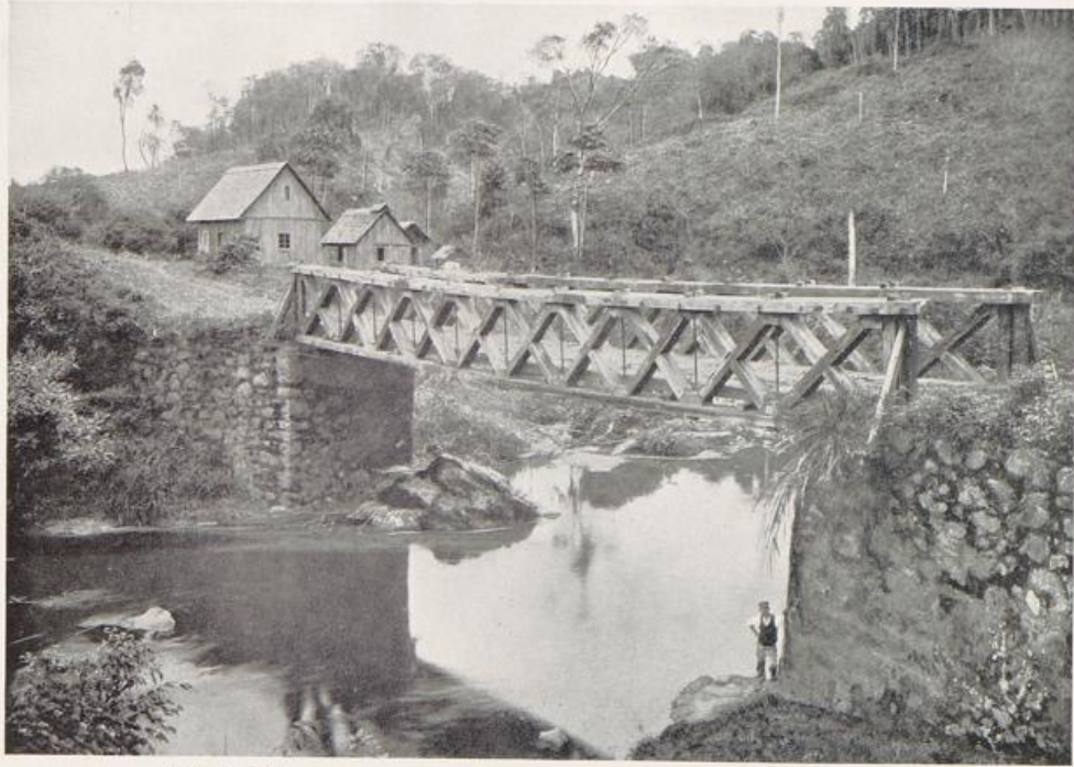
Brücke (Holz- und Eisenkonstruktion) über den Natal (Joinviller Hansa).
