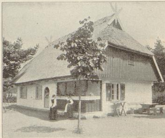
Abb. 4. Litauisches Haus in Jakobruh bei Tilsit. (Erbaut von der Litauischen Literatur-Gesellschaft als Baumuster und Sammelstätte litauischer Erzeugnisse.)
