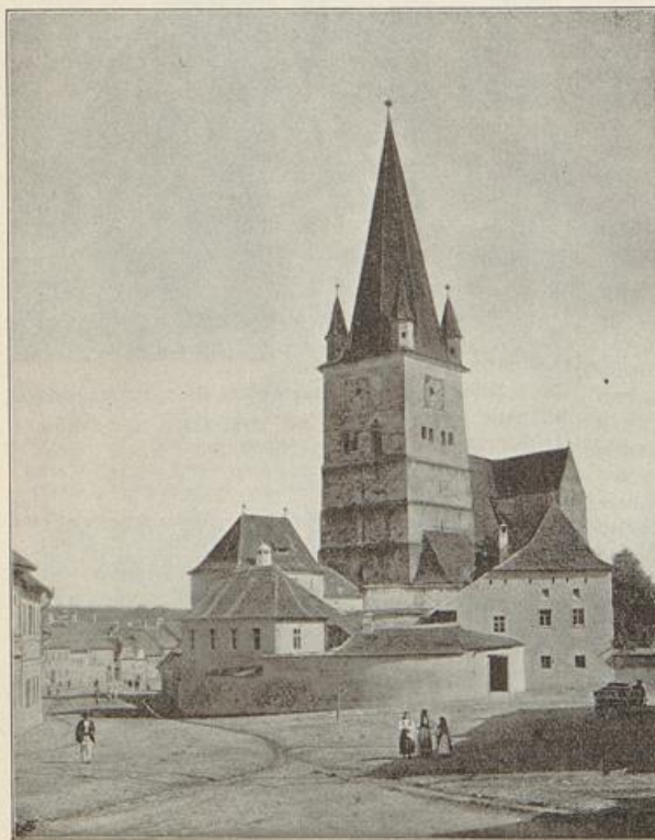
Abb. 50. Das Kirchenkastell in Heltau bei Hermannstadt. Heltau mit 2338 deutschen, 592 rumän., 238 magyar. Einw. (1900) ist der Hauptsitz der Wollweberei, die von 280 Meistern und rd 2000 auswärtigen Arbeitern betrieben wird. Die Befestigungskirche, ursprünglich romanischen Stils, ist im 16. Jahrhundert umgebaut.
