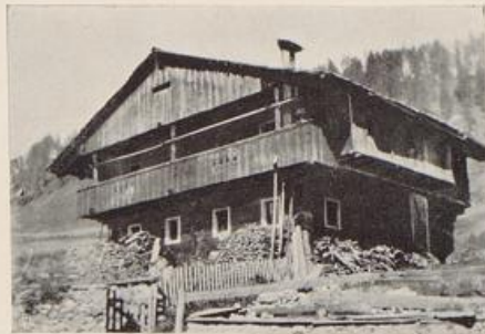
Haus im Weiler Prun (1257 m)
