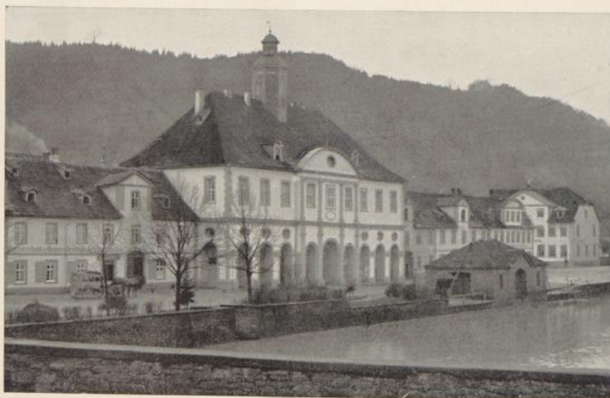
Hafenplatz mit Rathaus in Karlshafen an der Weser 1699 für französische Einwanderer erbaut
