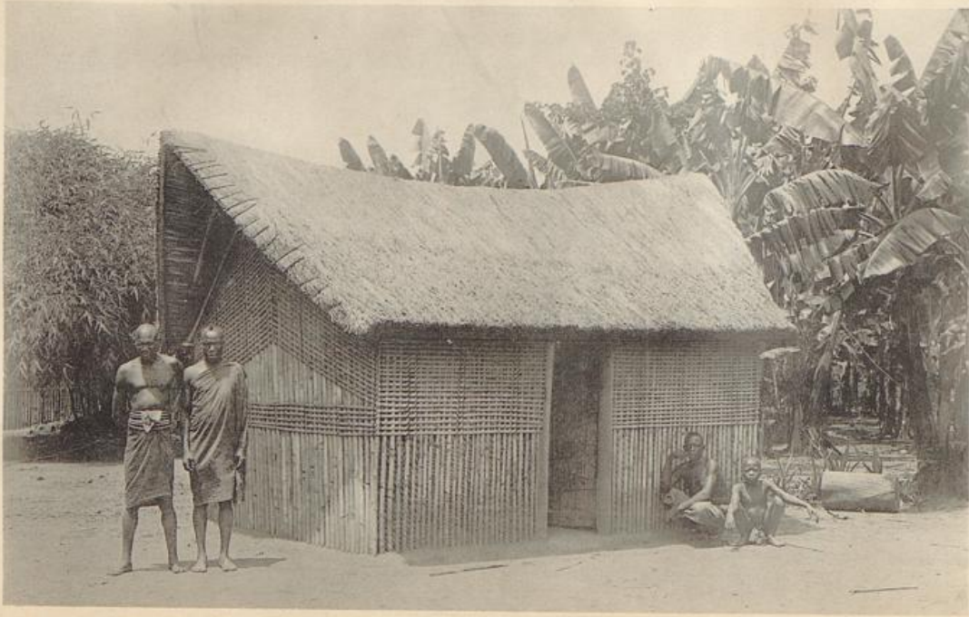
Haus der Wanyakyusa, deutsches Konde-Land (rechts im Hintergrunde Bananen, links Bambus). Die Häuser sind in überaus sauberer Weise aus Bambus hergestellt, dessen Zwischenräume von der Innenseite her mit kleinen Lehmklösschen ausgefüllt werden; das Dach besteht aus Stroh. Die Hütten liegen regelmässig innerhalb sehr gut gepflegter ausgedehnter Bananenhaine.
