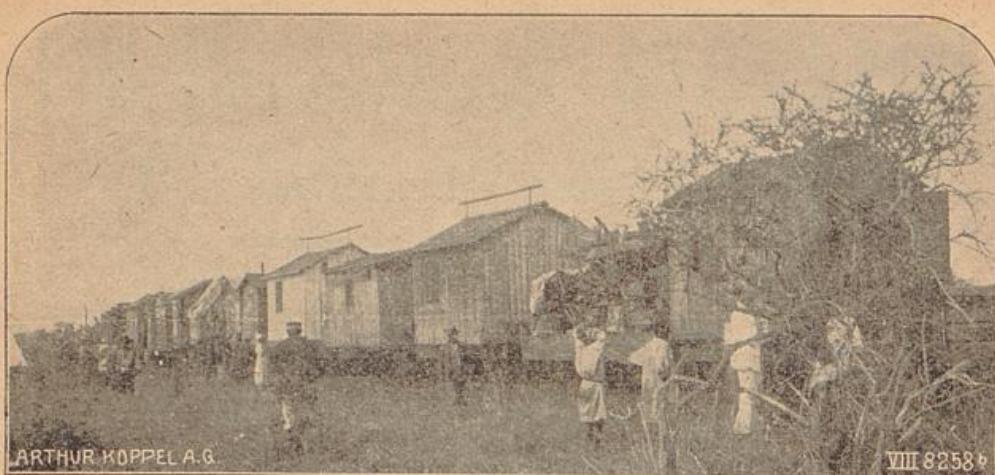
Bau der Otavibahn in Deutsch-Südwest-Afrika (Länge 578 km, Spurweite 600 mm). Die Oberbau-Kolonnen wechselt das Lager.
