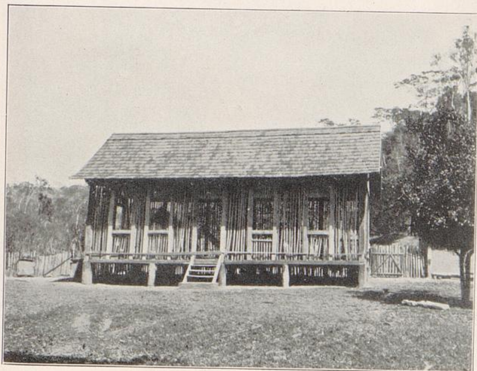
Haus im Bau.
