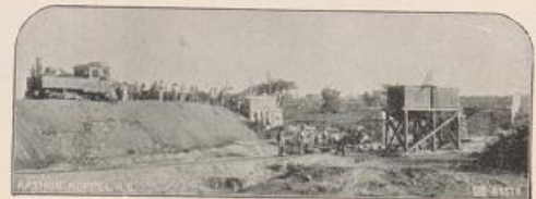
Otavibahn. Deutsch-Südwestafrika (Bauarbeiten).
