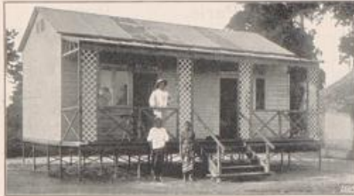
Transportables Wohnhaus aus Holz mit Eisen-Unterbau. (Nautschä-Togo.)
