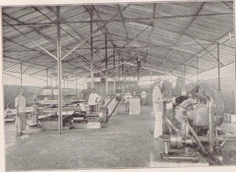
Maschinen-Schuppen einer Teefaktorei. (Patent-Baueisenkonstruktion von 1 ELLIESEN & MICHAELIS, HAMBURG.)
