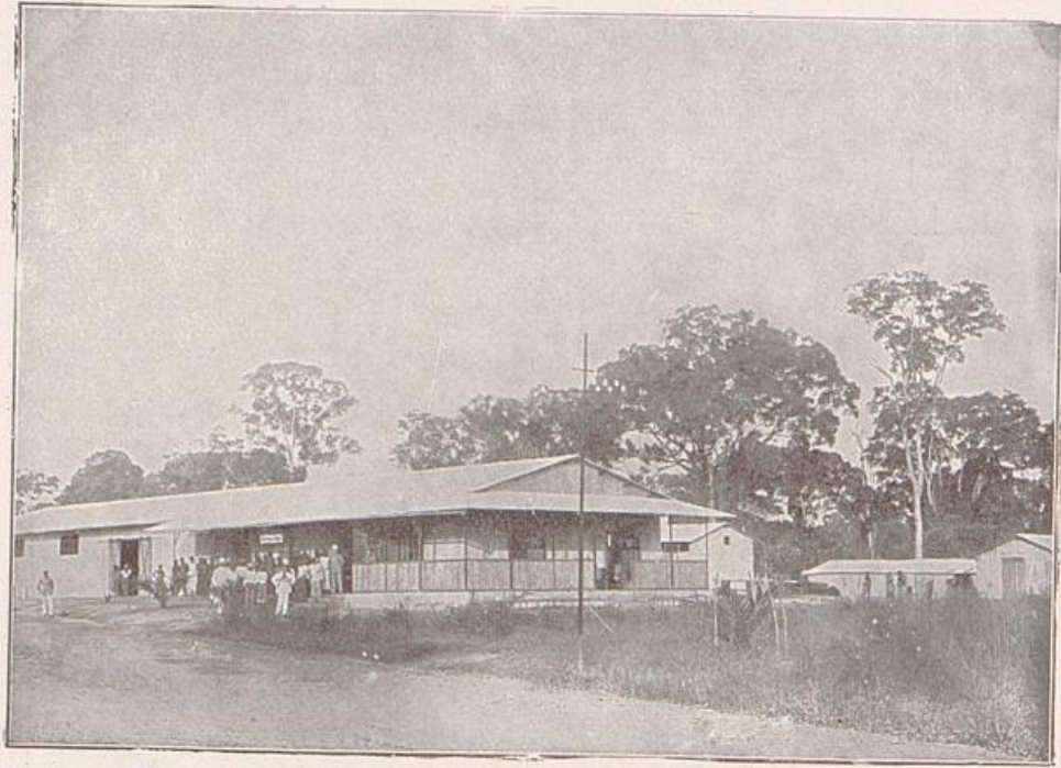
Laden u. Warenschuppen mit anschliessenden Wohnräumen in Kribi (Süd-Kamerun) errichtet aus Patent-Baueisen-Konstruktion, eingedeckt mit „REX“ Astralit-Dach.
