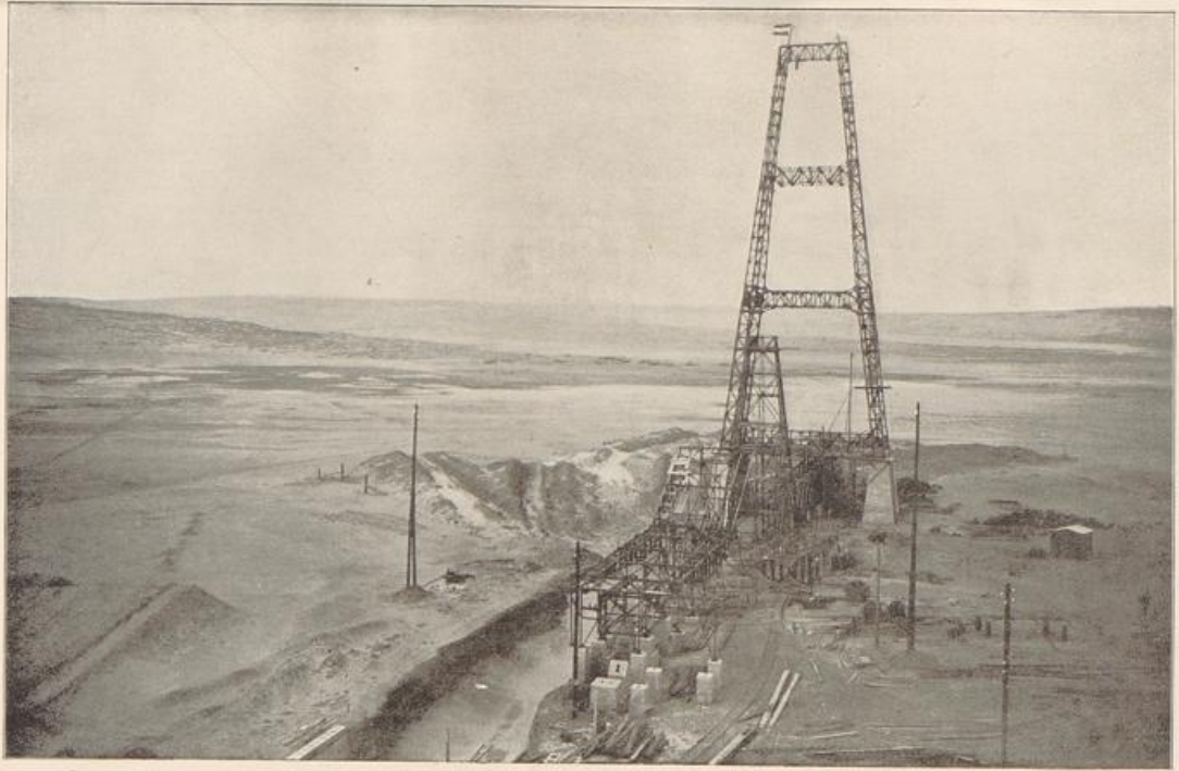
Koloniale Bergbau-Gesellschaft m. b. H.: Galdenbahn Nordblockwäsche in Montage. (Phot. Kirchhof 1914.)
