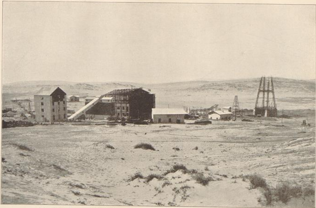
Koloniale Bergbau-Gesellschaft m. b. H.: Nordblockwäſche im Bau 1914. (Phot. Kirchhof.)
