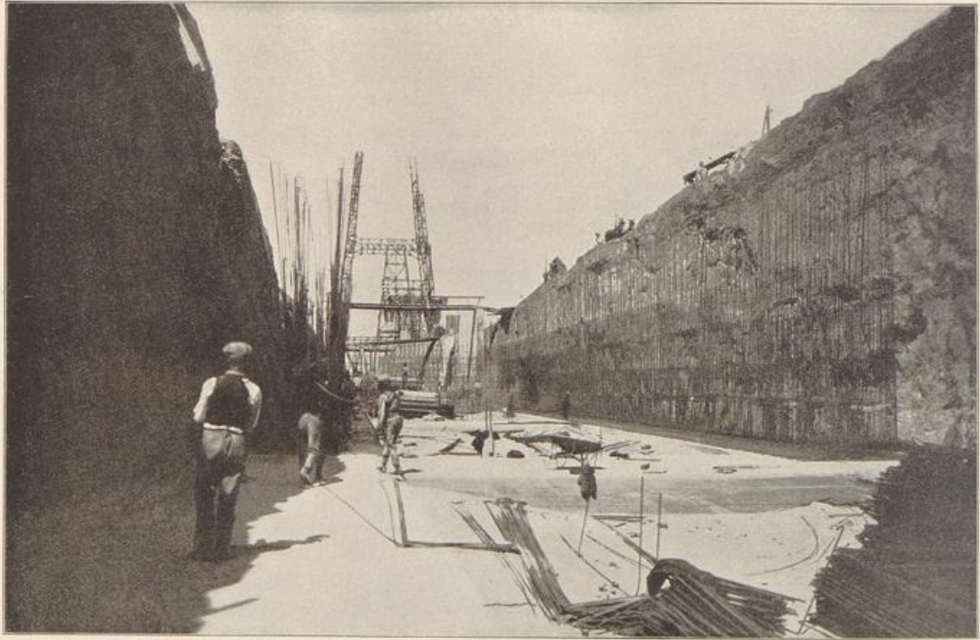
Koloniale Bergbau-Gesellschaft m. b. H.: Klarbecken Nordblockwäsche: Eisenbetonarbeiten. (Phot. Kirchhof 1914)
