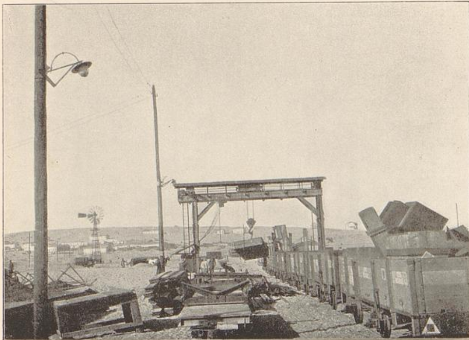
Koloniale Bergbau-Gesellschaft m. b. H.: 1. Löffelbagger, elektrisch betrieben. 2. Umladefran, Station Kolmanskuppe. (Phot. Ollendorff.)
