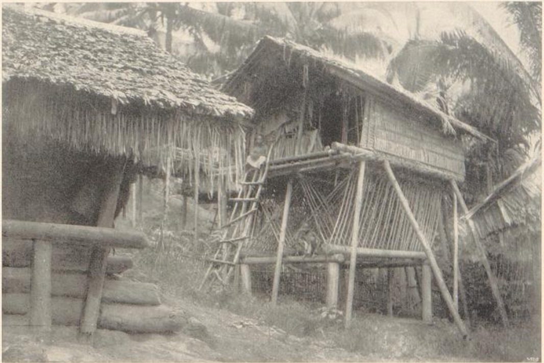
Salomon-Inseln: eigentümliche Bauart eines Hauses in einem Dorfe in der Nähe von Kieto. Die Häuser sind zum Schutz vor Feuchtigkeit und wilden Tieren so hoch über dem Erdboden gebaut
