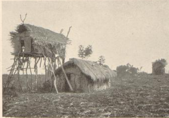
Dobbertin phot. Eingeborenenwohnung mit Vorkamrhaus auf Pfählen. Die Ernte wird wegen des Ingejietes möglichst hoch über dem Boden verwahrt
