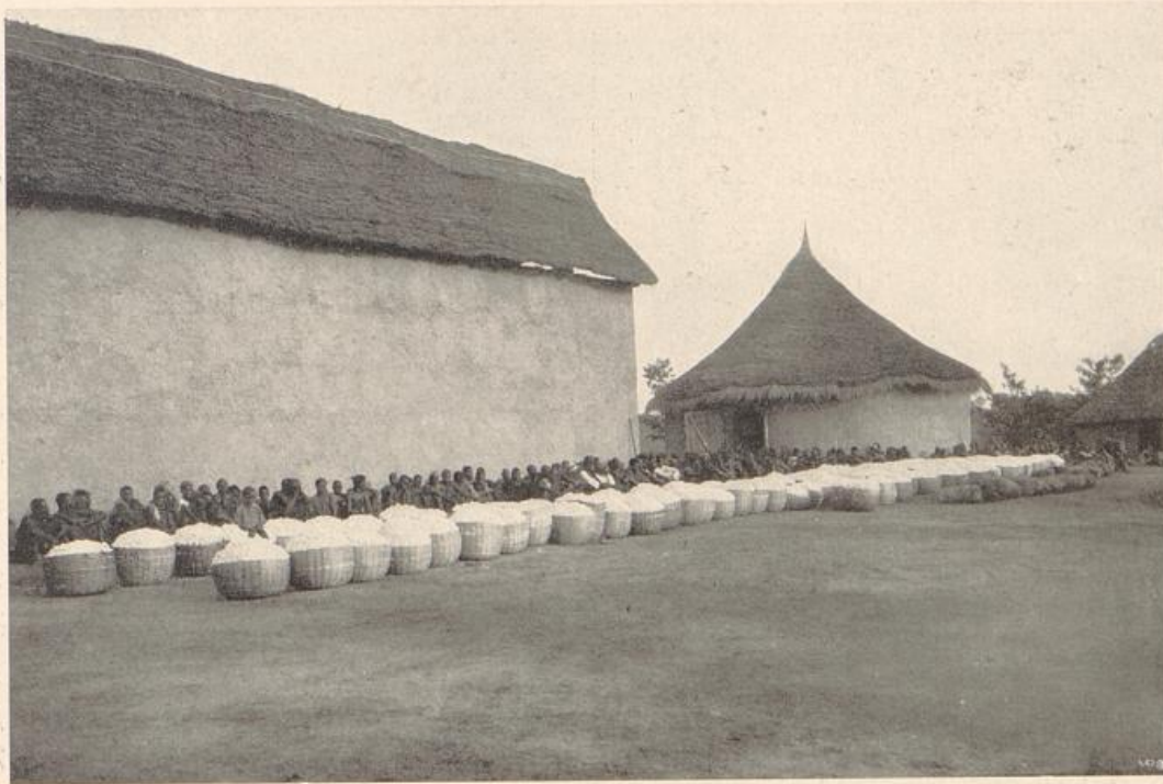
Baumwollverkäufer von Bogu in Sokode, Nord-Togo. Die Togobaumwolle fängt an von Bedeutung für den Markt zu werden
