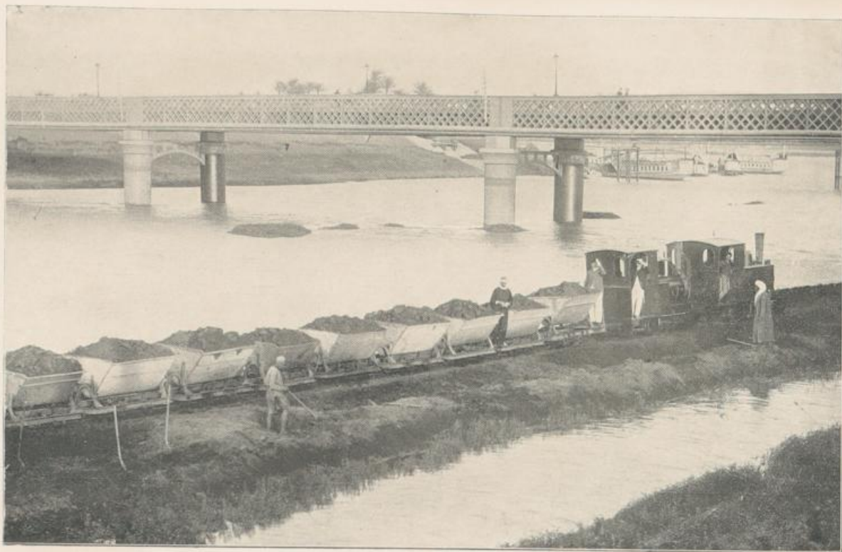
Erdtransport durch eine Feldbahn mit Lokomotivbetrieb geliefert von der Aktiengesellschaft für Feld- und Kleinbahnen-Bedarf vormals Orenstein & Koppel, Berlin.
