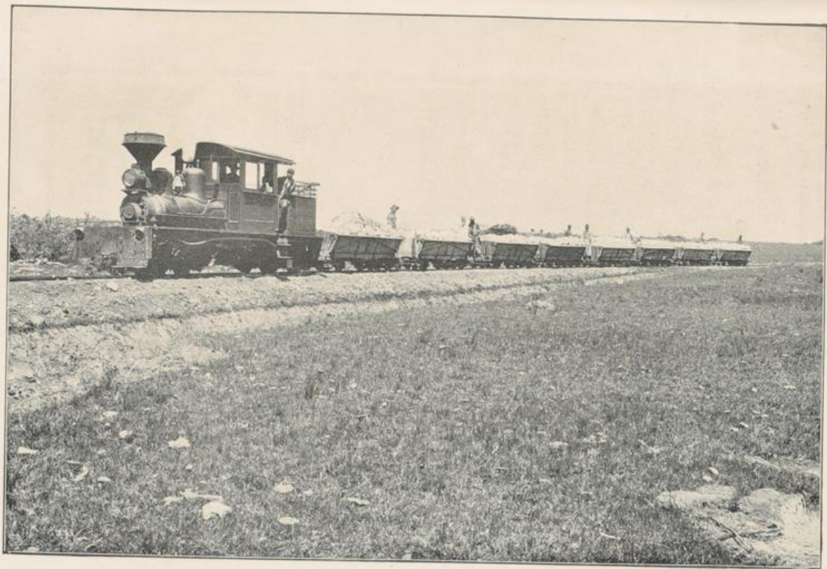
Steintransport durch eine Feldbahn mit Lokomotivbetrieb geliefert von der Aktiengesellschaft für Feld- und Kleinbahnen-Bedarf vormals Orenstein & Koppel-Berlin.
