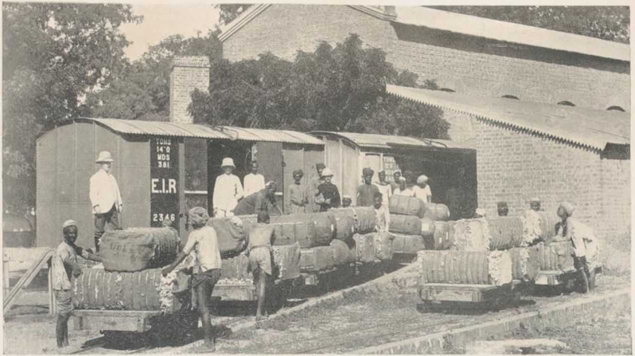
Umladen von Baumwolle von den Staatsbahnwagen auf die Schmalspurwagen. Bahnanlage der Arthur Koppel A. G.
