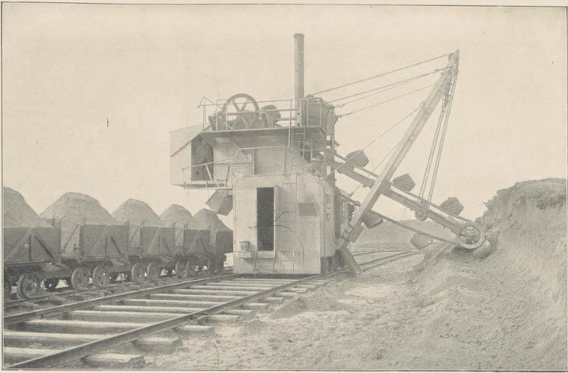
Baggerarbeiten durch einen Hochbagger. Stündliche Leistung 120 cbm geliefert von der Aktiengesellschaft für Feld- und Kleinbahnen-Bedarf vormals Orenstein & Koppel, Berlin.
