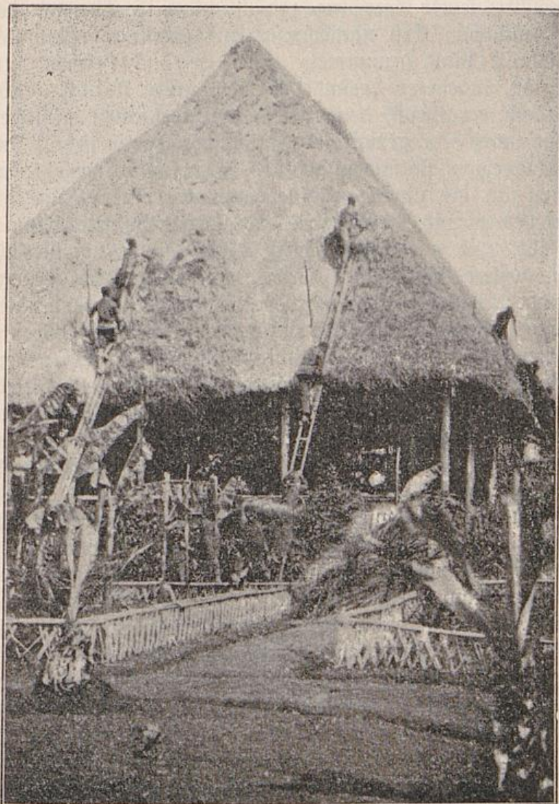
Balis beim Grasdecken eines Hauses in Baliburg Nach einer Photographie von Dr. Zintgraff
