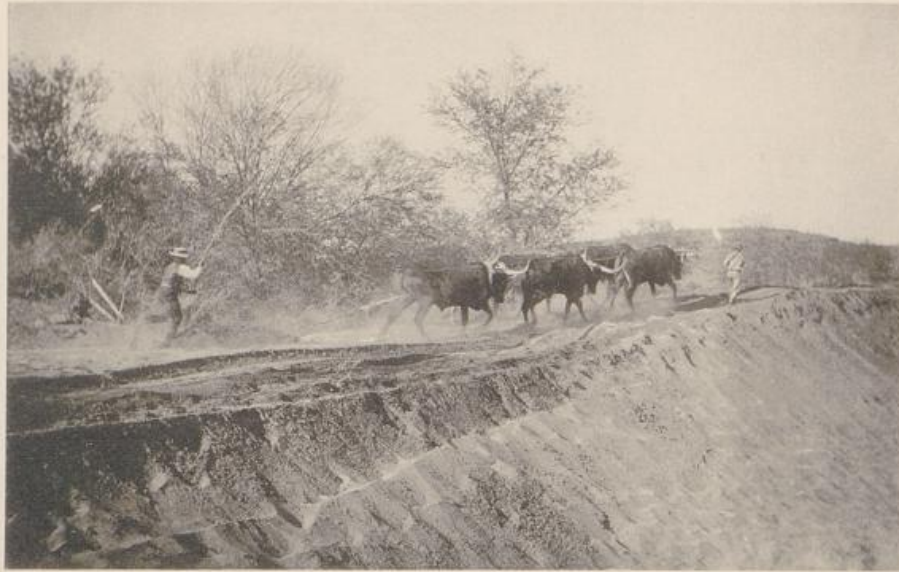
KAIS. Bau eines Staudammes über den Kaisfluss.
