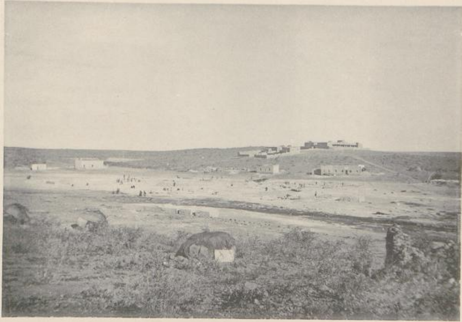
GIBEON. Marktplatz und Stationsgebäude.
