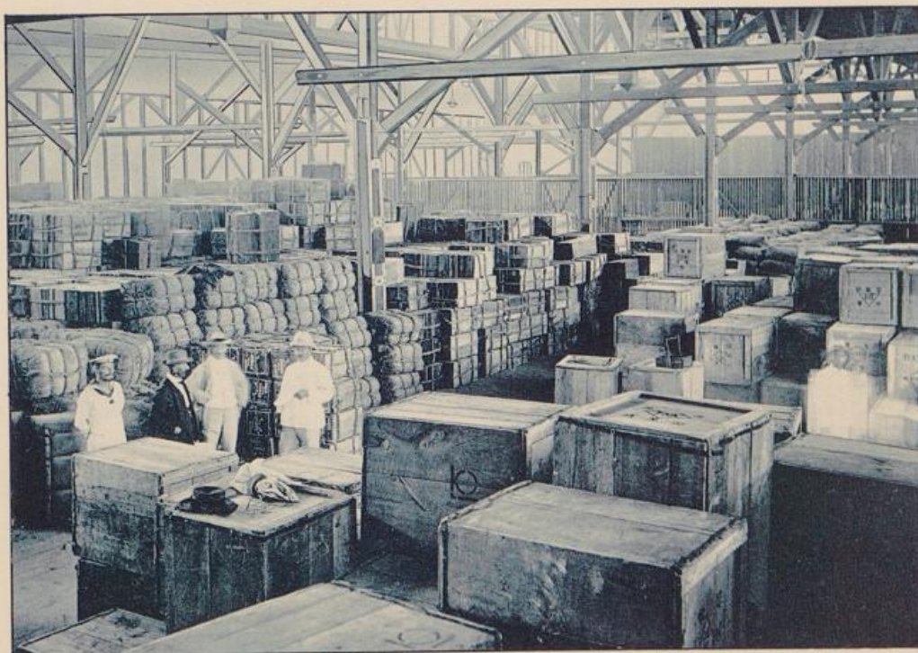
b. Blick in einen Lagerschuppen.
