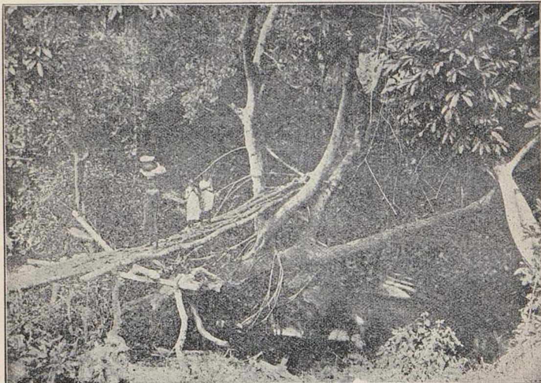
Brücke über den Dayi bei Gbedzigbe-Hohoe (zu S. 11).
