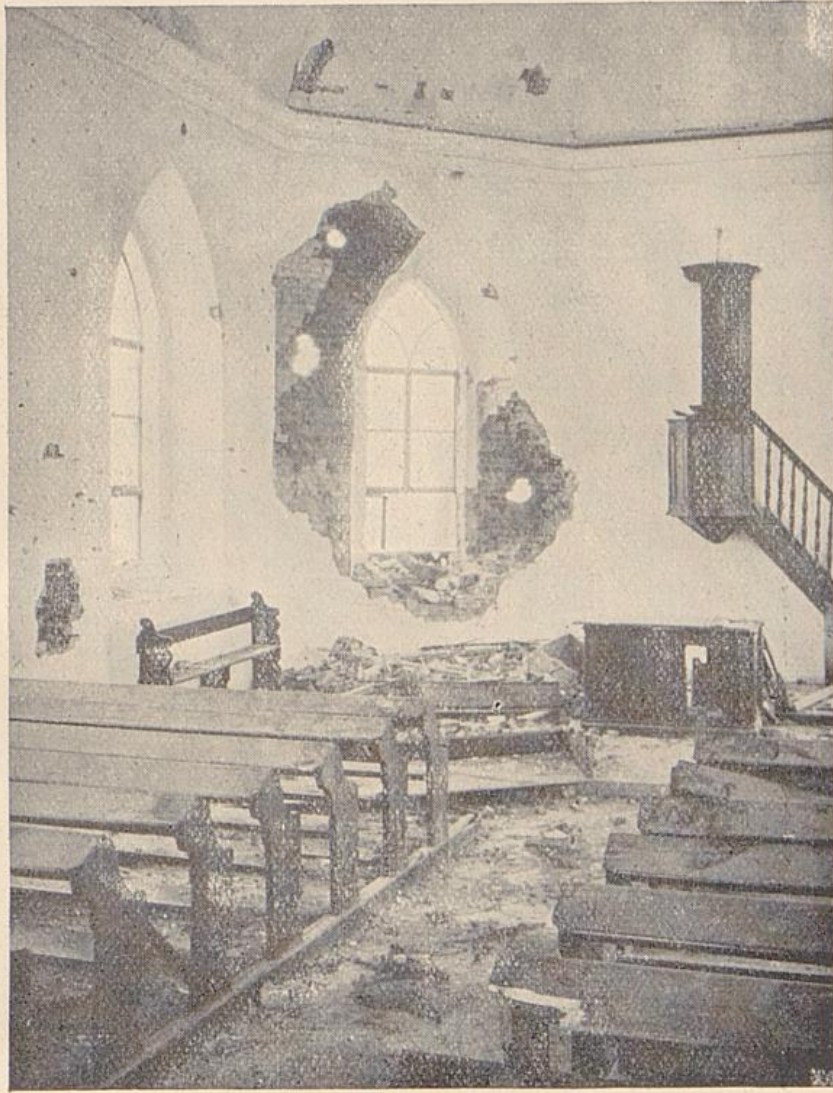
Inneres der zerschossenen evangelischen Kirche in Ugartzberg.
