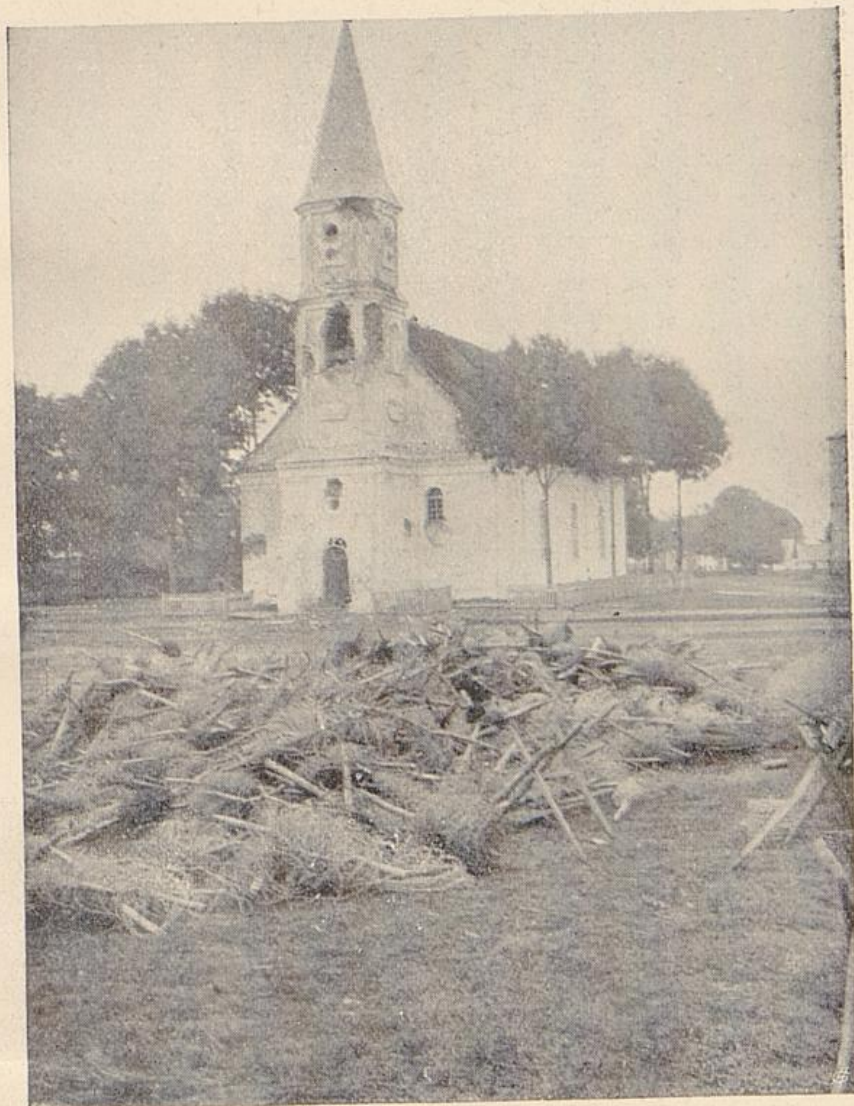
Evangelische Kirche in Josefsberg nach der Beschädigung.
