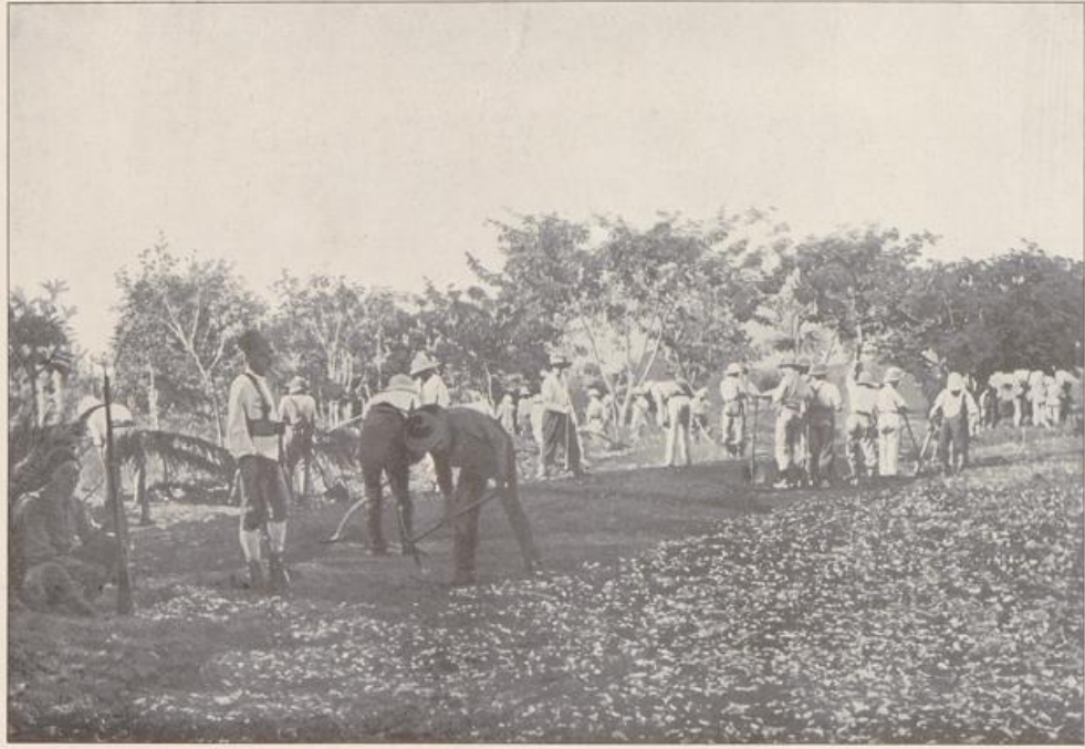
Neuanlage der Straße von Abomey nach Kandi.
