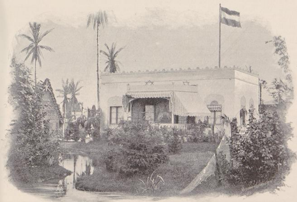
Gebäude des Arbeitsausschusses (Rückseite).
