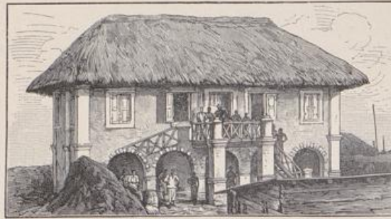
Schulhaus in Kleinpopo.
