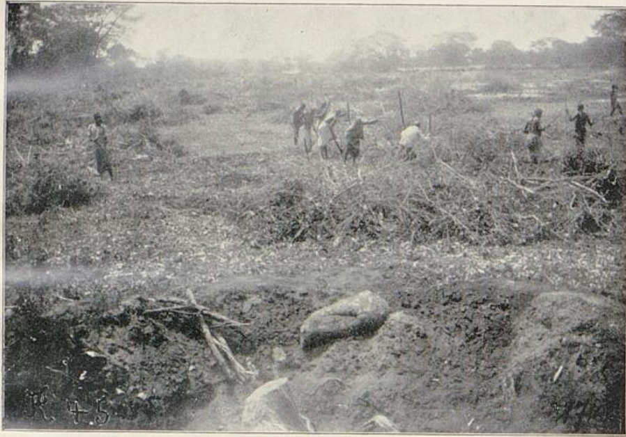
Aufräumungsarbeiten nach dem Brennen.
