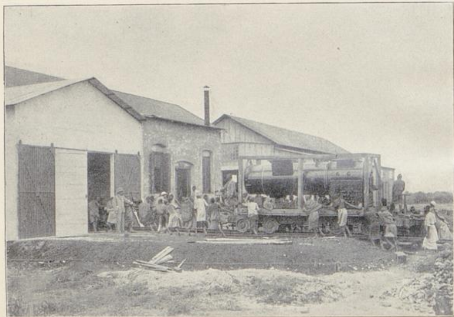
Einbringen der 80-PS.-Lokomobile in das Maschinenhaus.
