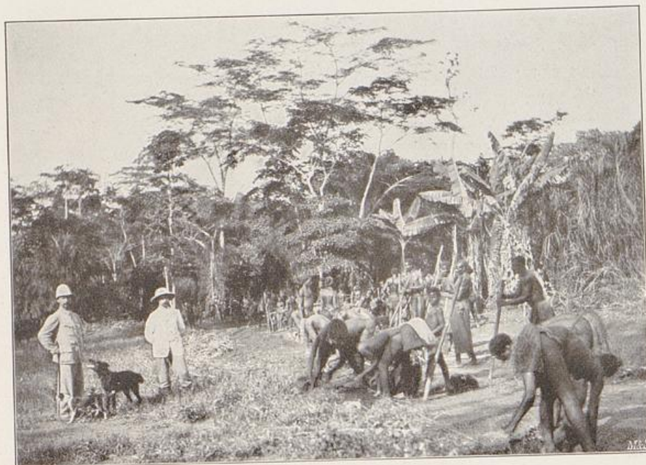
Strassenbau in Jaunde 1905.
