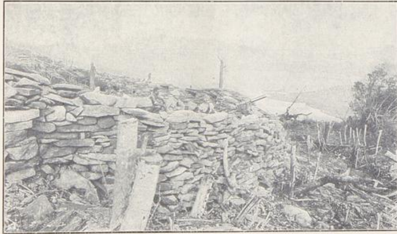
Kapitänlt. v. Koschizky phot. Mauerbefestigung auf dem Dschokadschberge nach der Einnahme und Abholzung.
