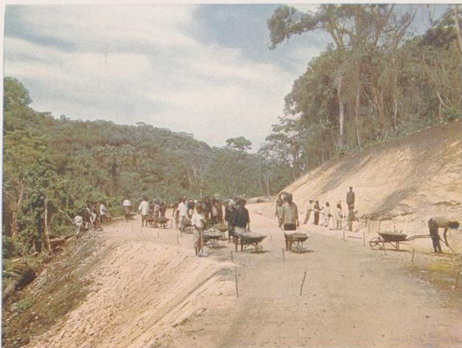
Straßenbau am Françoisbaf.
