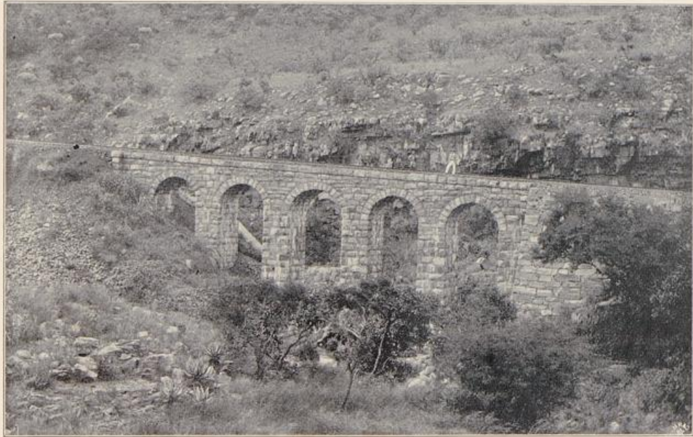
Eisenbahn- Viadukt bei Waterval Boven am Krokodilflusse .
