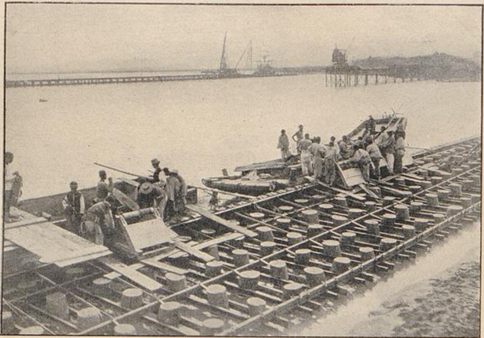
Bau der Kohlenmole
