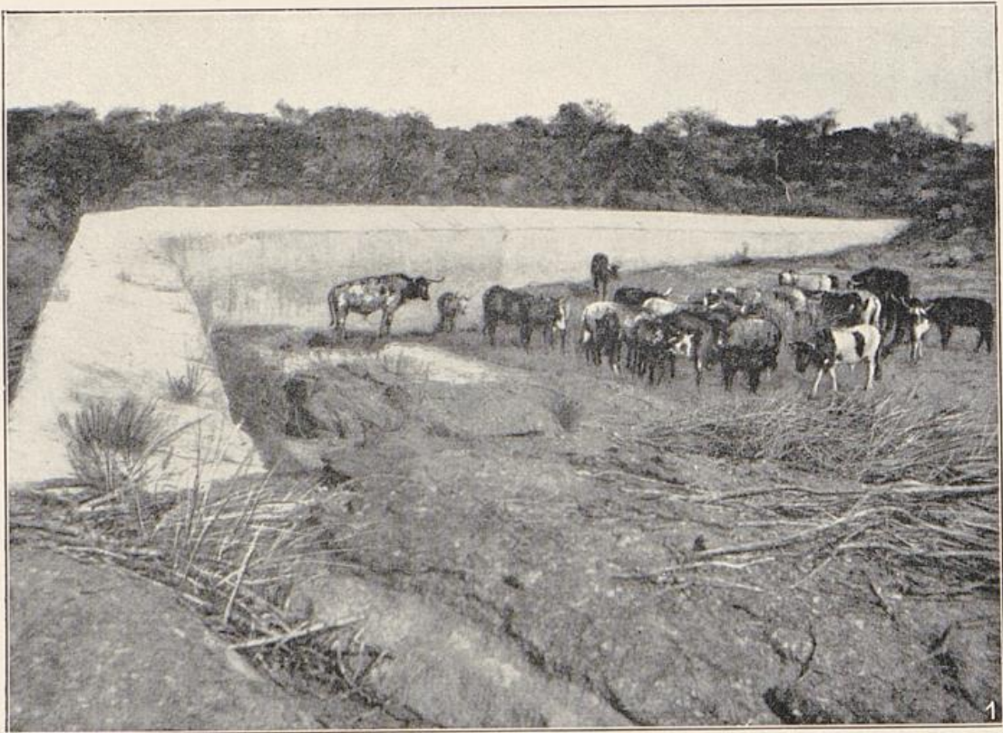
Staudamm in einem südwestafrikanischen Rivier. (Wo die Viehherde steht, befindet sich das Staubecken, das infolge allzulangen Regenmangels ausgetrocknet ist.)
