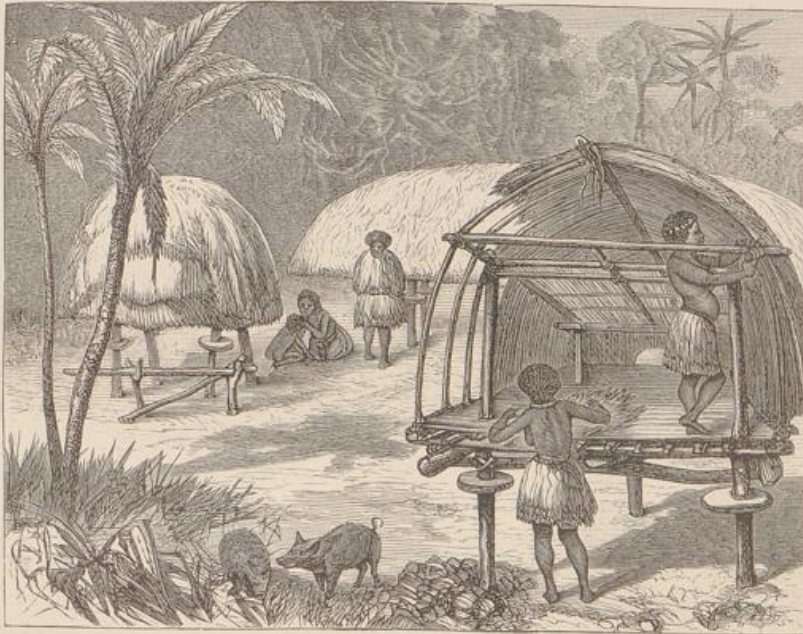
Bau eines Papua-Hauses.
