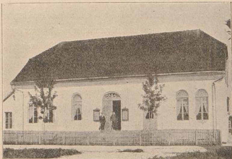
Municipal-Kammergebäude in Joinville.
