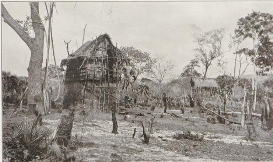
Abb. 2. Pfahlhäuser im Rowumatal bei Ntschitschira.
