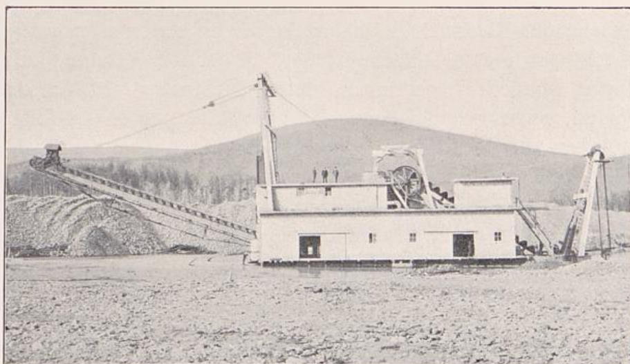
Bild 31: Bagger mit elektrischem Antrieb zur Aufarbeitung der Goldkiese an der Bärbachmündung.
