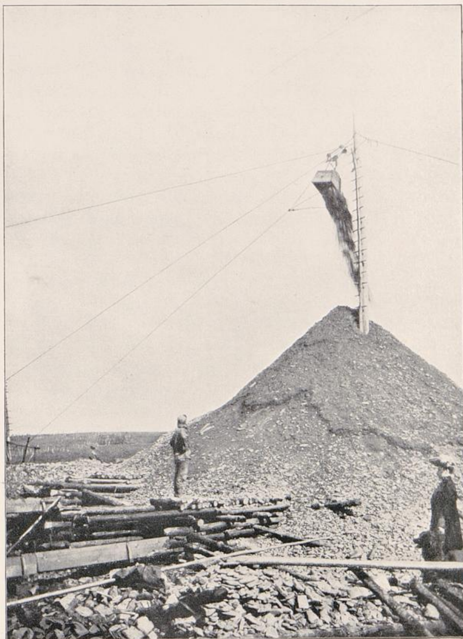
Bild 39: Minentätigkeit am Clearyfluß im Fairbanksgebiet. Der aus der Grube beförderte goldhaltige Kies entleert sich selbsttätig und bildet mit der Zeit einen ansehnlichen Berg.
