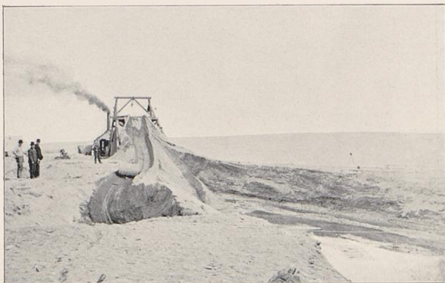
Bild 60: Mechanische Vorrichtung zum Hochbringen der Goldkiese (Brown's Scraper) am Strand von Nome.
