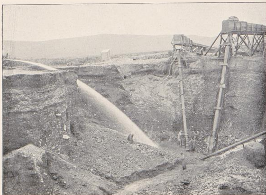
Bild 50: Direkte Bearbeitung der Diluvialkiese am Gletscherbach mit abwärts gerichteten Wasserstrahlen durch die Miocändeichgesellschaft.
