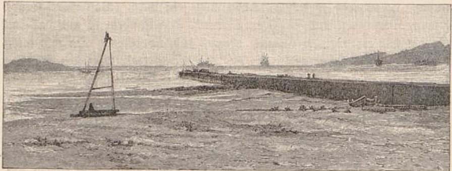
Im Bau befindliche Landungsbrücke
