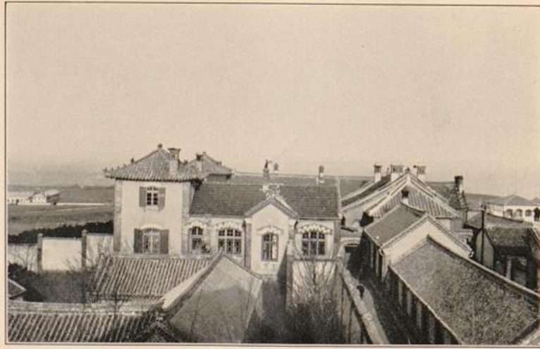
Teil des Schulkomplexes des A. G. P. M. V. in Tsingtau.
