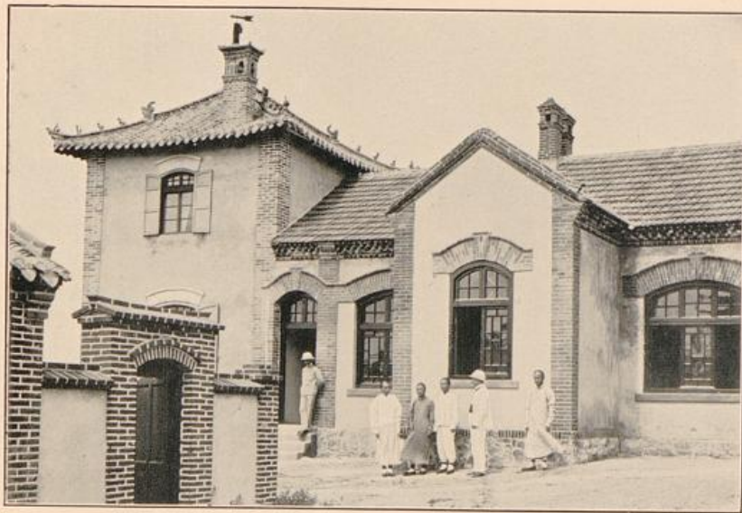
Speise- und Küchegebäude der Höheren Knabenschule des A. G. P. M. V. in Tsingtau.
