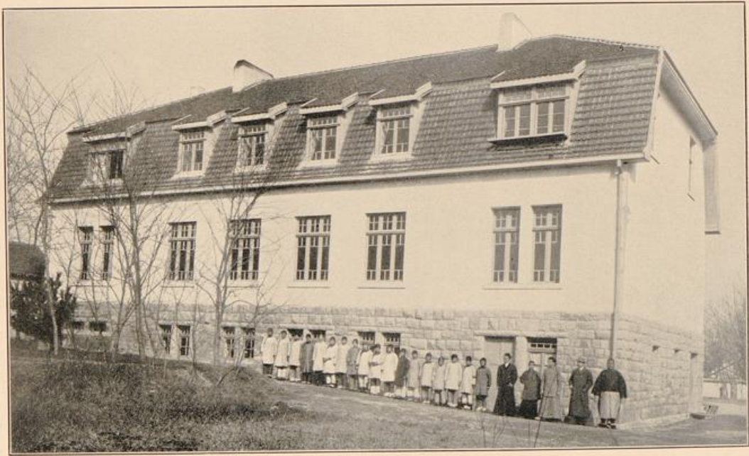
Schu-San-Schule. Schulhaus mit Oberklasse und Lehrerkollegium.
