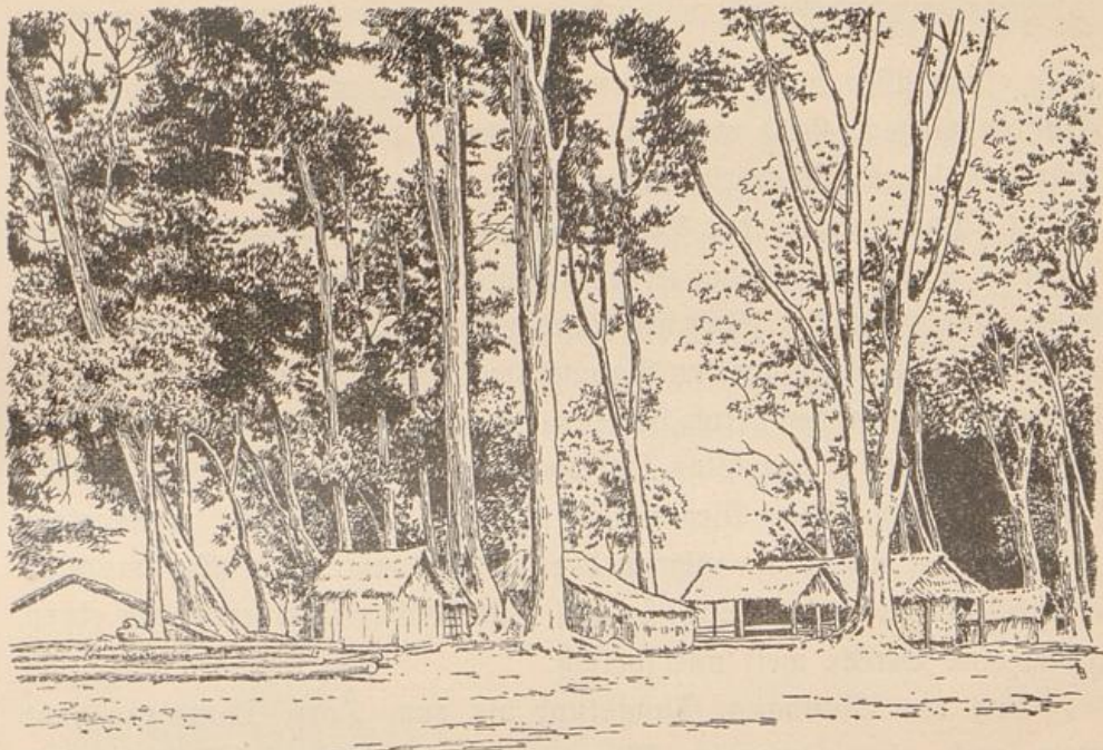
Bild 41. Unsere Lager und Wohnhäuser am Strand zu Lamasong. A. B.
