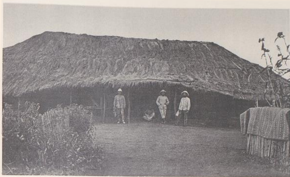
31. DIE STATION KOROGWE DER D.-O.-A. GESELLSCHAFT, VORDERANSICHT DES HAUPTGEBÄUDES.
