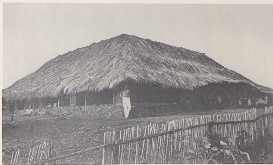
32. DIE STATION KOROGWE DER D.-O.-A. GESELLSCHAFT, SEITENANSICHT DES HAUPTGEBÄUDES.
