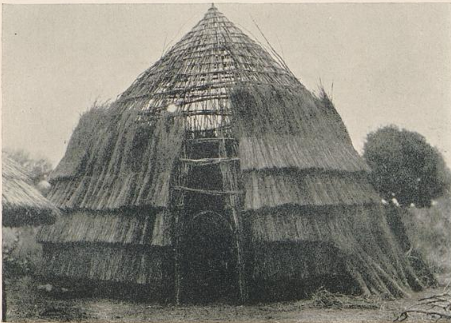
Hütte im Bau
