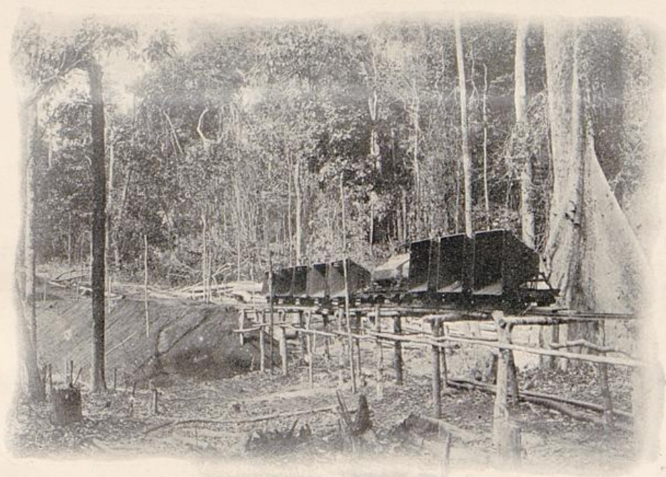
Dammschüttung im Urwald.
