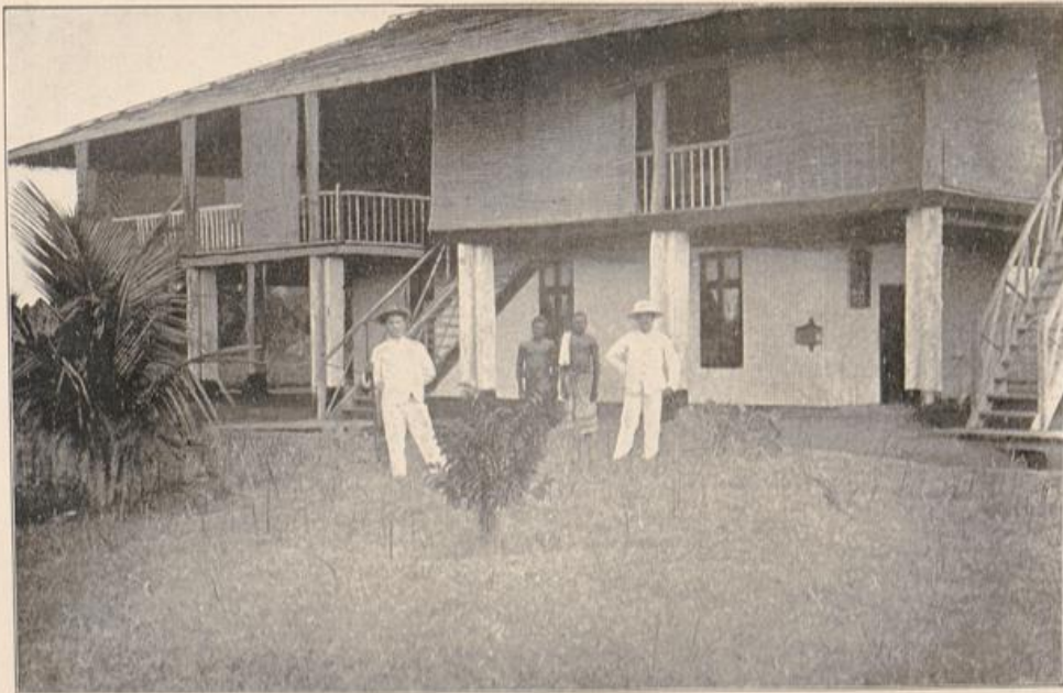
Das Hauptdienstgebäude in Stephansort.
