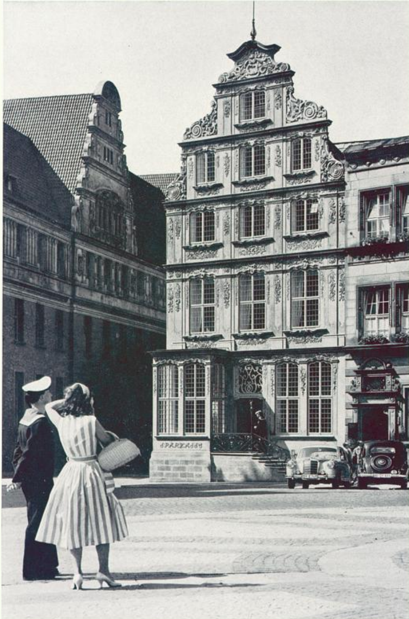
Der Sparkassenneubau Am Markt, Ecke Langenstraße, ist unter Verwendung der sogenannten Pflügerschen Fassade, die vor der Zerstörung an der Schlachte gestanden hat, errichtet worden und ist ein originelles Beispiel denkmalpflegerischer Arbeit. Der Vorwurf, hier sei „Baudenkmalpflege auf Rädern“ betrieben worden, verstummt hier vor dem überzeugenden Ergebnis der Arbeit des Architekten BDA Eberhard Gildemeister und des Baudenkmalpflegers Dr. Stein.
