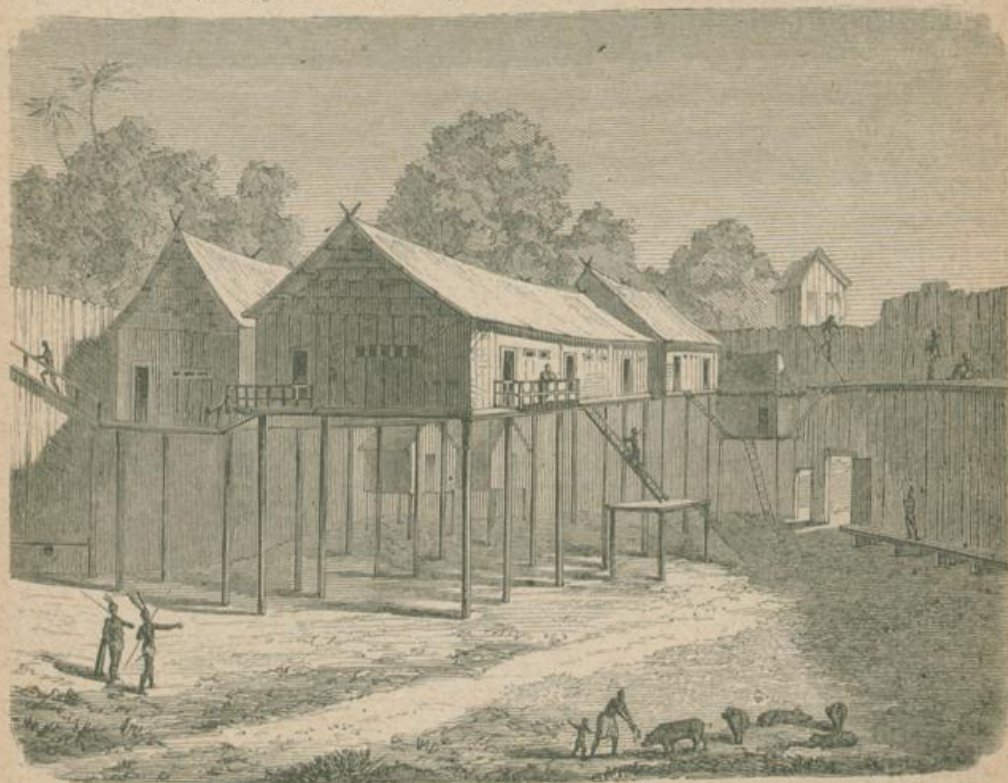
Pfahlwohnungen der Dajaks.
