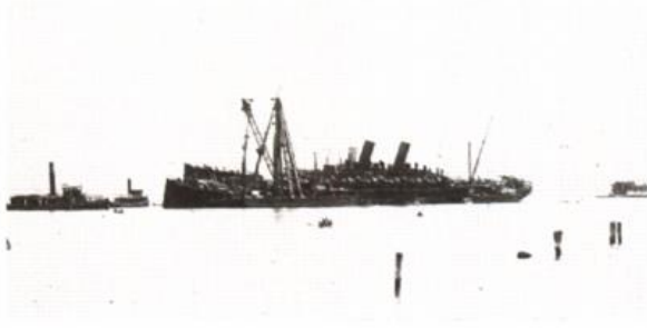
Abb. 11: Bergungsarbeiten mit einem Schwimmkran und zwei Schleppdampfern an den ausgebrannten Lloydampfern »Bremen« (Vordergrund) und »Main« (Hintergrund) Anfang Juli 1900. (Hoboken Historical Museum)
