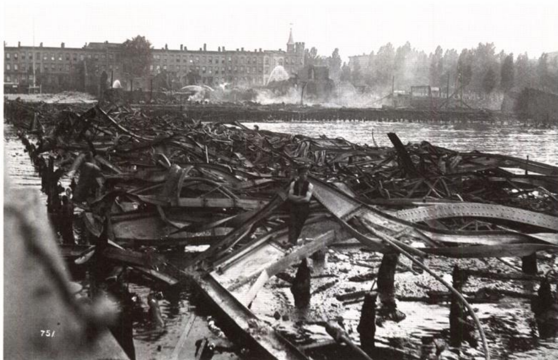
Abb. 10: Die abgebrannte, erst als ein Holzbau mit Eisenträgern 1896/97 erneuerte Pier I, im Hintergrund Nachlöscharbeiten. (Archiv Mystic Seaport/Connecticut)
