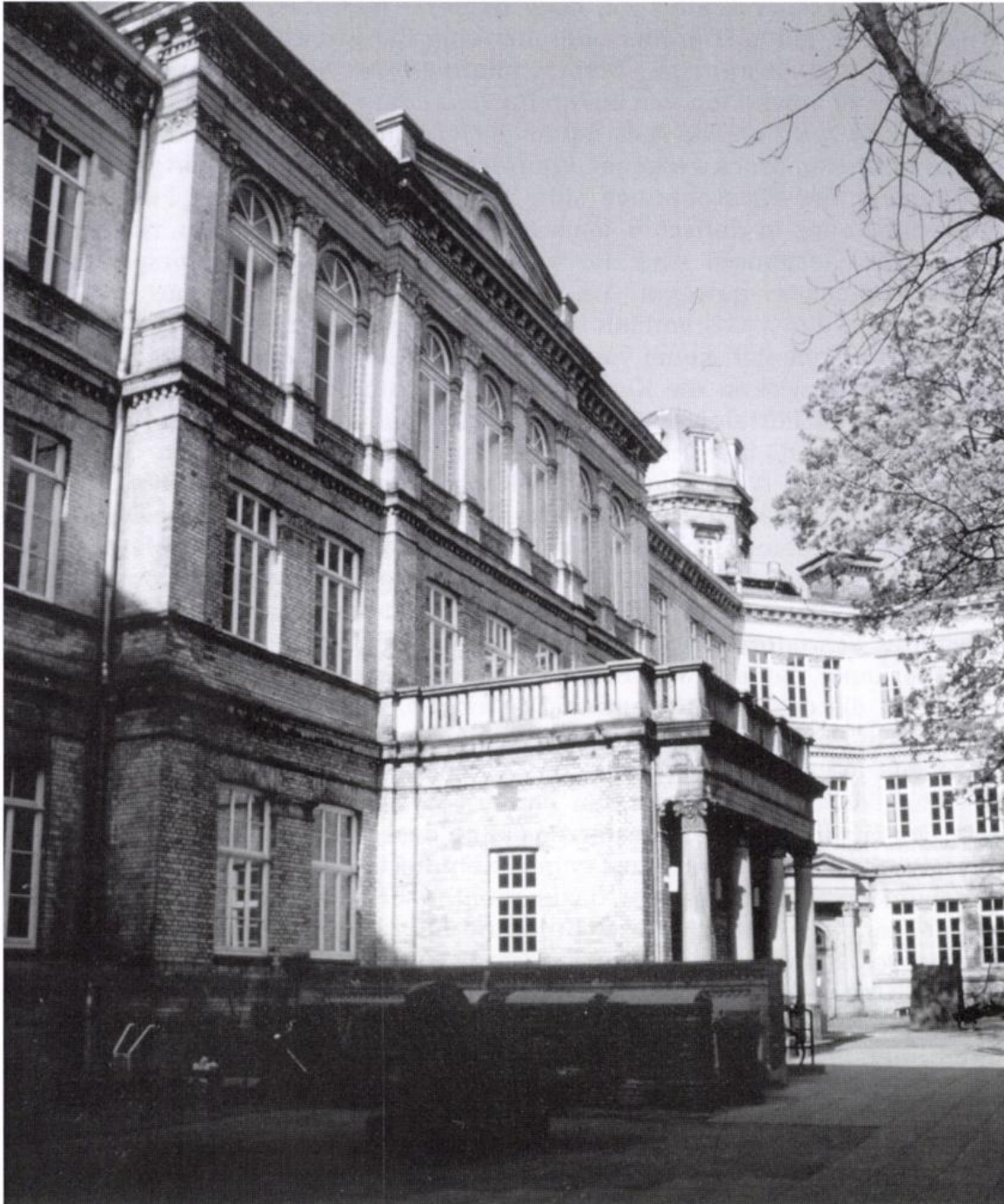
Abb. 7: Ehemaliges Altes Gymnasium, Mitteltrakt.
