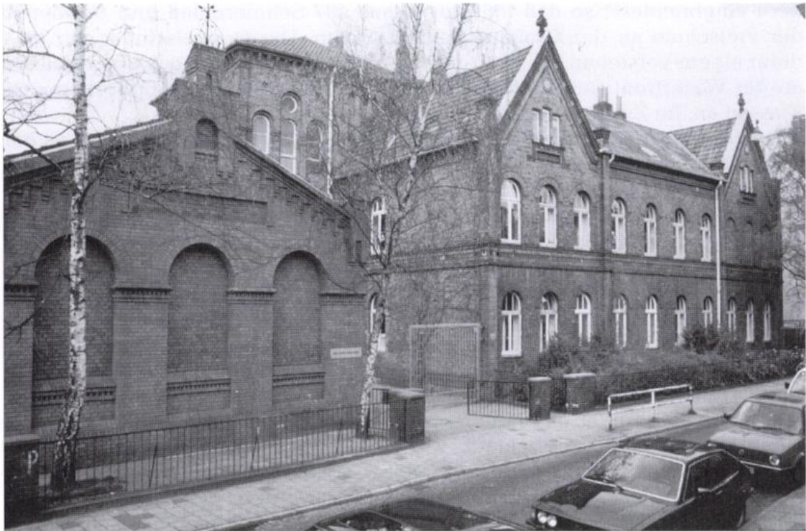
Abb. 1: Schule an der Schmidtstraße. Links Turnhalle von 1890, rechts Trakt mit ehemaligen Lehrerwohnungen.
