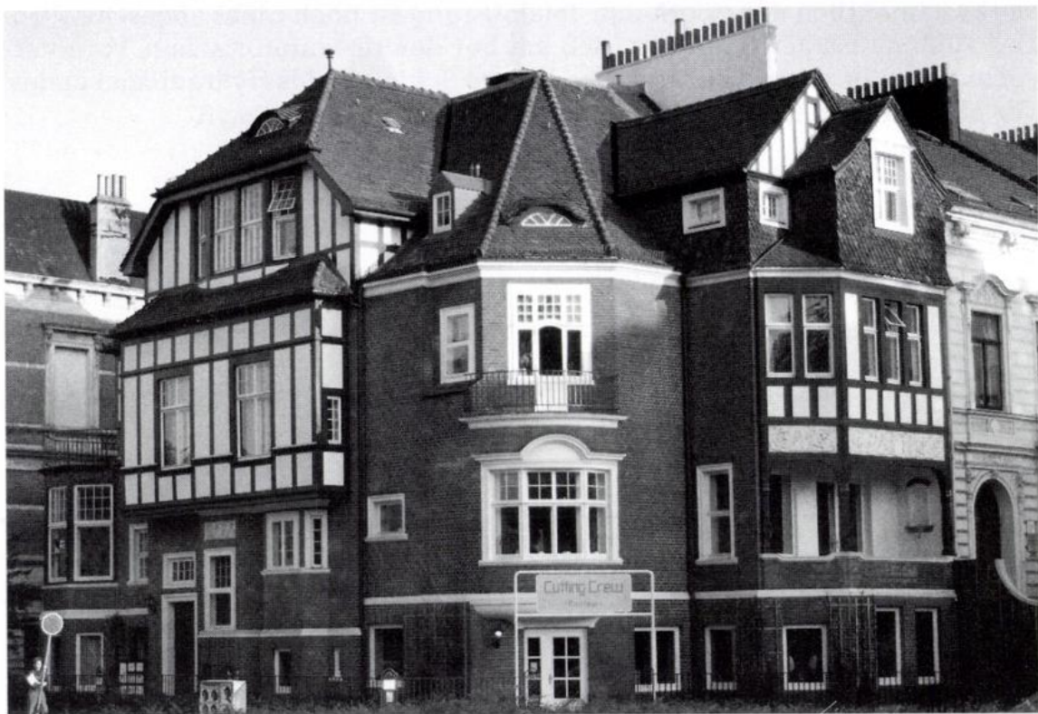
Abb. 18a, 18b: Hollerallee 67, „Villa am Stern“, vor und nach der Instandsetzung 1990
