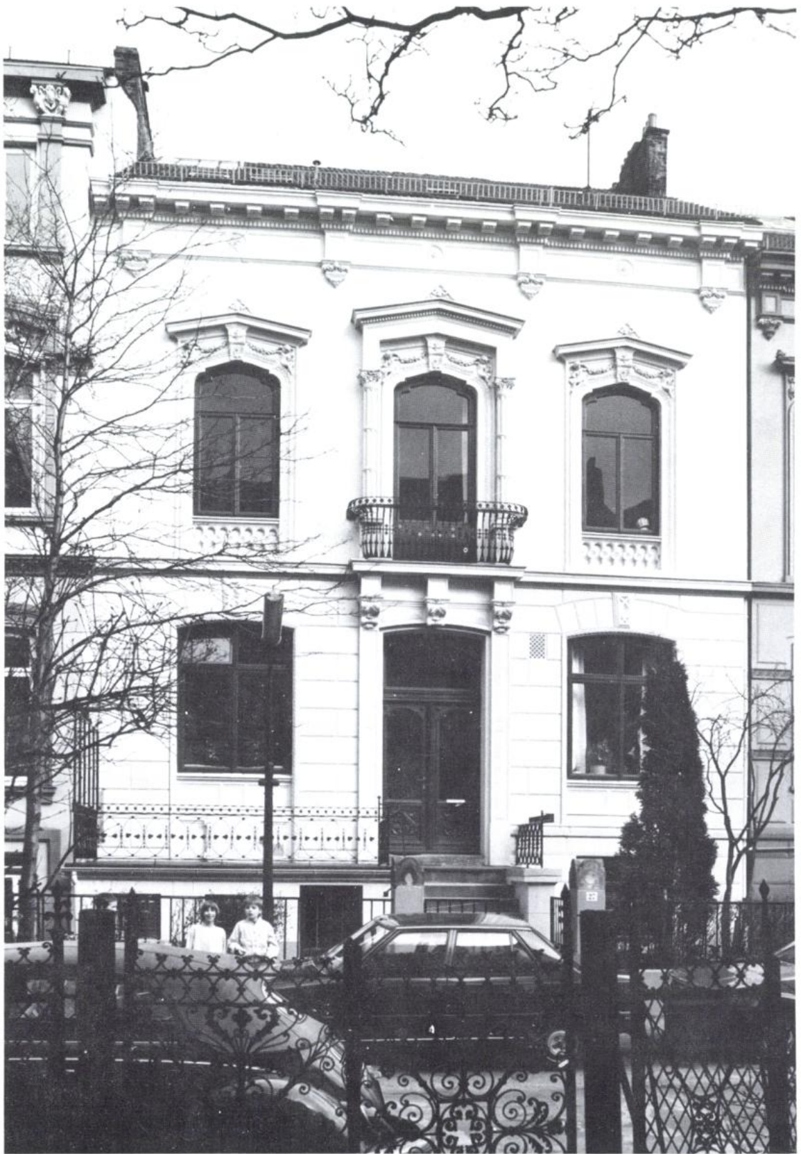
Abb. 12: Mathildenstraße 27 nach der Renovierung.
