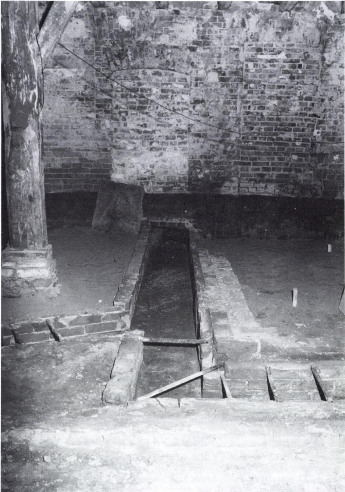
Abb. 5: Alte Hafenstraße 30, Altes Packhaus, früher „Kito-Haus“. Blick in die Ausgrabungen.
