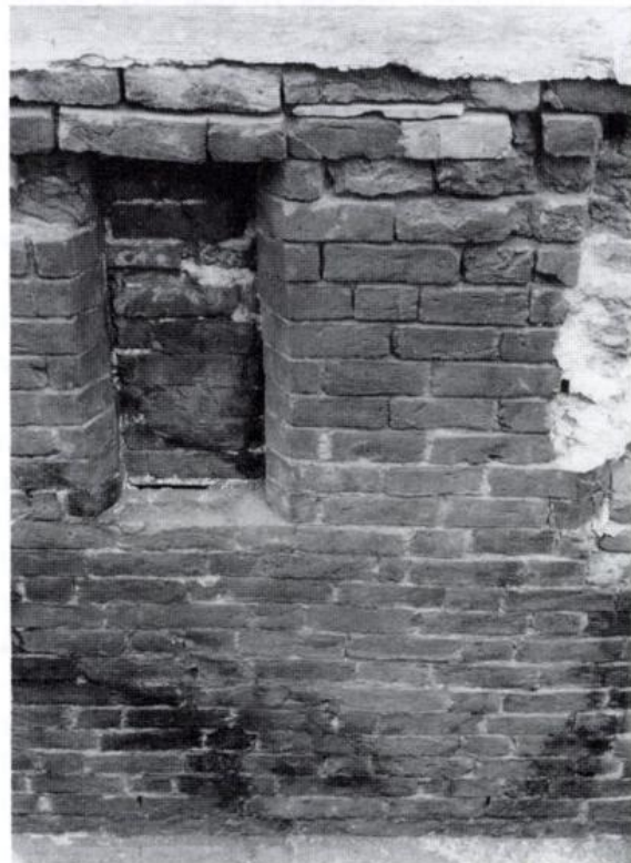
Abb. 4c: Sandstraße 3. Kellerfenster des äl- teren Kellers, vor 1580.
