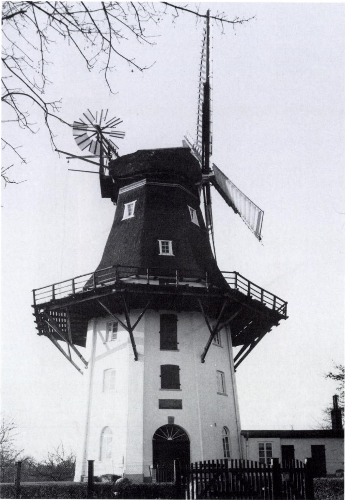
Abb. 14: Die Oberneulander Mühle nach der Restaurierung.
